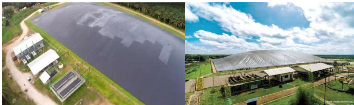
Gambar 4. Pembangkit Listrik Tenaga Biogas/ Methane Capture (Biolistrik) dalam Pengolahan Limbah PKS Sawit di Provinsi Riau dan Kalimantan Timur
